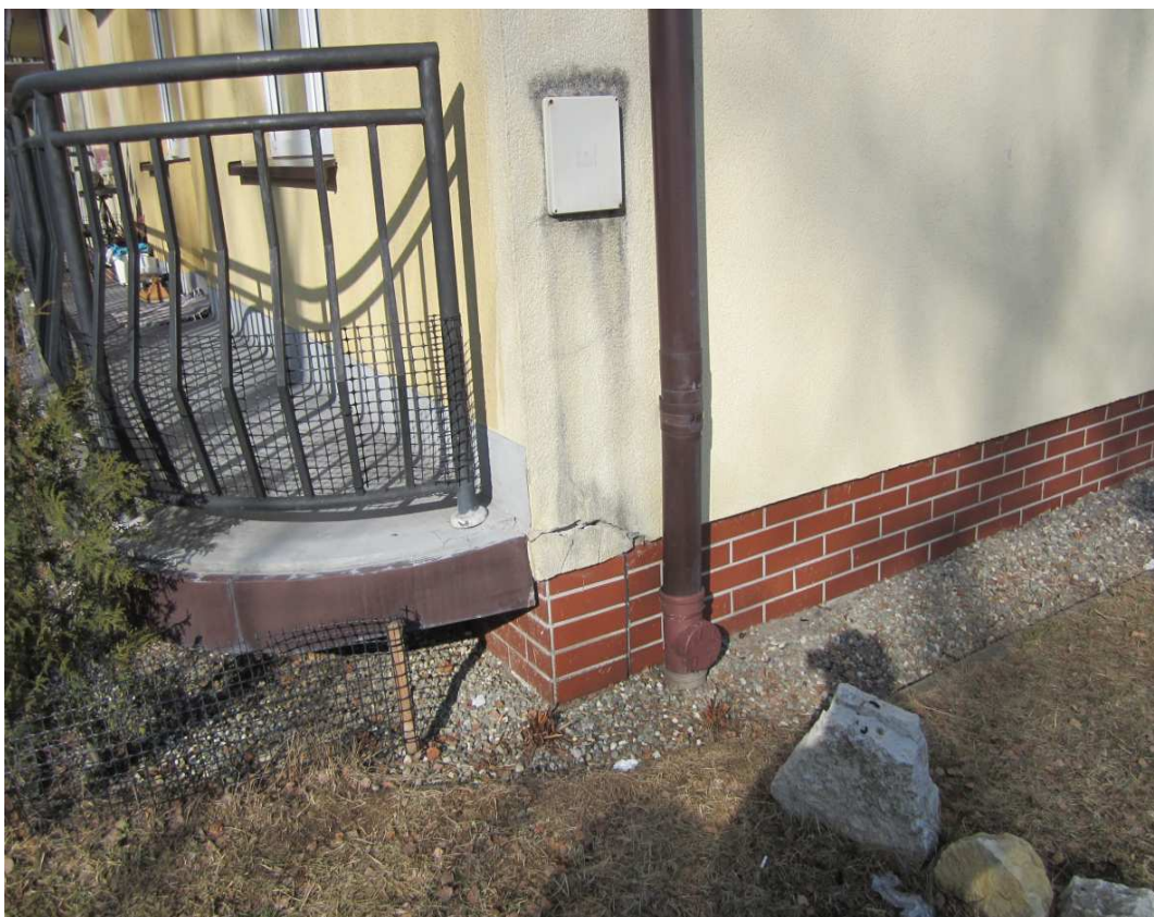
3. Elewacja południowo-zachodnia i południowo- wschodnia (fragment) - narożnik, cokół.
