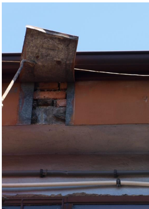
Fot. 11 Odkrywka 11, 12 - gzyms
