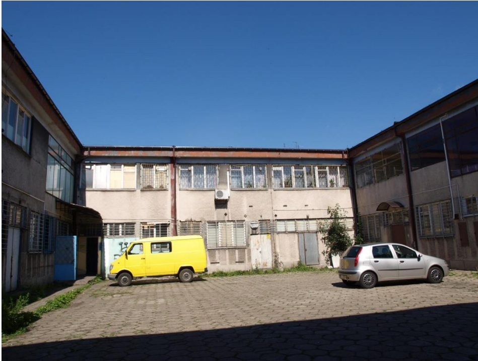
Fot. 2 Widok pawilonu od strony dziedzińca
