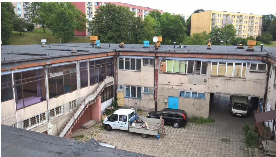
Fot. 3 Widok pawilonu od strony dziedzińca
