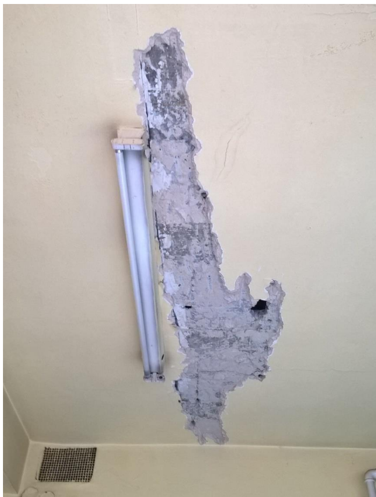
Fot. 10 Odkrywka nr 6 - strop nad parterem
